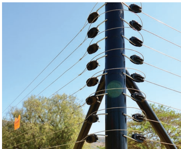
POSTES DE CANTO, POSTES TERMINAIS E RESPETIVAS ESCORAS
